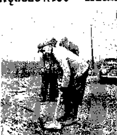
Na zdjęciu naprawa drogi Rększowice - Hutki, w dużej mierze wykonanej przez...
