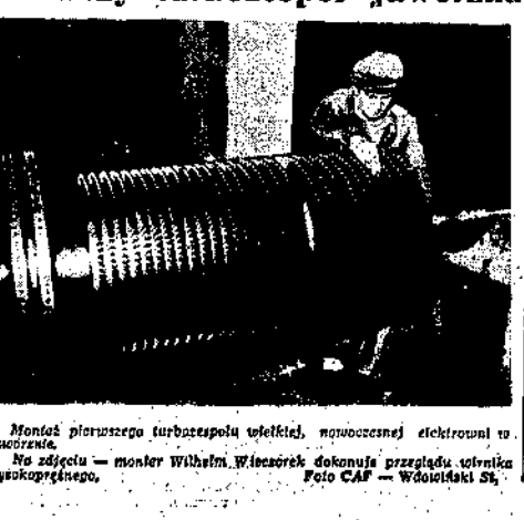
Montaż pierwszego turboszętu w Jaworznie. Na zdjęciu — monter Wilhelm Włosek dokonuje przeglądu turbiny turkopiętowej. Foto CAF — Wdwiolaki Sł.
