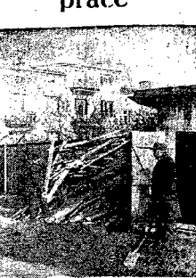
...na terenie budowy dużego, nowoczesnego hotelu robotniczego...
