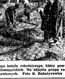
...na terenie budowy dużego, nowoczesnego hotelu robotniczego...
