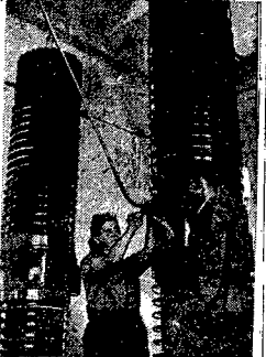
Montaż urządzeń elektrowni-giganta w Miechowie...
