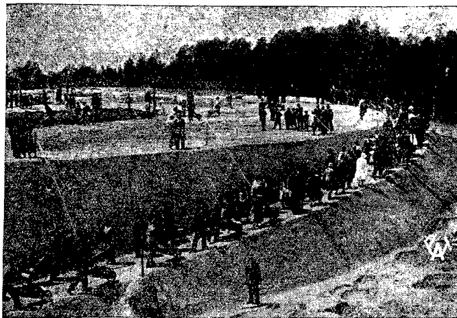
Na Sowińcu. Praca przy sypaniu kopca Marszałka Piłsudskiego.
