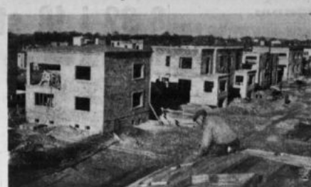
W Poznaniu trwa budowa 32 domków jednorodzinnych przeznaczonych dla pracowniczek szkolnictwa wyższego. 10 domków zostało oddanych już w użyciu. W budowie pozostałych 22 zostanie zakończona w roku przyszłym. Roboty budowlane są systemem gospodarczym przy użyciu materiałów zastępczych i odpowiednio użytkowych. Na zdjęciu: fragment budowy osiedla. Fot. CAF.
