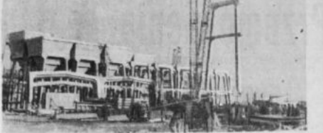
Jedna z najnowocześniejszych palarni gliny szamotowej na świecie powstała w niepozornym sąsiedztwie Jaroszewca. I przysłał jej urzędnicy i metody budowy fachowcy określają jako niemal rewolucję techniczną.
