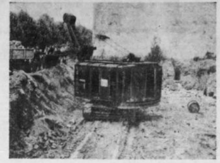
...w III Alei gromadzili się tłumy przechodniów, by obserwować prace ekipy, drążącej wykop pod fundamenty domów. Kilka tygodni wcześniej w zabudowie tej pięknej ulicy, z zachowaniem wszelkich ostrożności dokonano lawy pod nowe gmachy.
