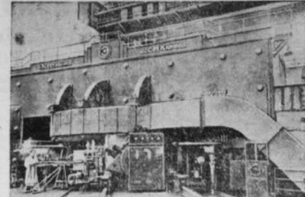
W Instytucie Zapędzeń Jądrowych Akademii Nauk ZSRR na zdjęciu spektroskopotron fotonowy elektronowy, komora, w której przeprowadzają się jony, potężna pompa do wyciągnięcia próżni i generator wysokiej częstotliwości. Fot. CAP.
