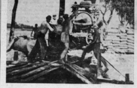
Zgodnie z programem wyborczym Frontu Narodowego Polnietosa Rofa Narodowa w Gryficach (wł.) szerzejbiej przeprowadza remonty, drog i budowa mostu na trasie Kamień - Gryfice. Na zdjęciu: Prace przy budowie mostu drogowego. Fot. CAF - Podoliki
