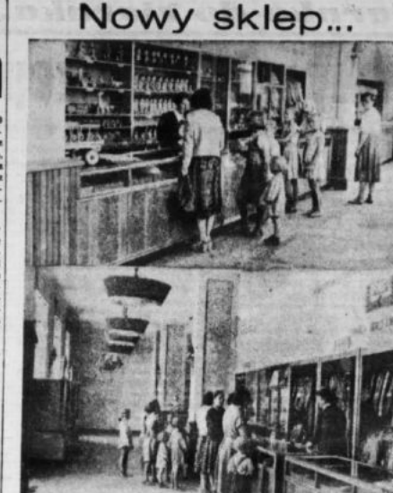
MHD z artykułami dziecięcymi, otwarty niedawno przy ul. Nowowiejskiej w dzielnicy Śródmieście odznacza się doskonałym zaprzęgiem i pięknym estetycznym wnętrzem...
