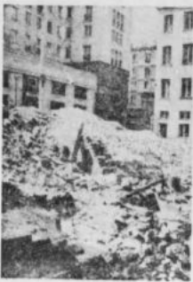
Niepiękny widok mają mieszkańcy przy ul. Piłsudskiego 12. Widać ślady po pożarze, który w nocy 14 września 1944 roku zniszczył budynek. Obecnie trwa remont i prace wykończeniowe.
