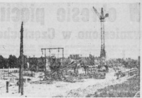
Budowlanowie 4 oddział przy ul. Kasprzaka na Bielskiej rozpoczęli już prace nad ugrzaniem. Na planie budowy widoczny obręb 45-tonnowy dźwig samochodowy. Podaje on w pułkownik zaprawę robotnikom pracującym przy dźwigu. Od pulku rozpoczął podawanie prefabrykacji przybrosznych i żerdzi. Wzrostu stropów, klatki schodowych, obramień okiennych. Niedługo budowni mogli tam zobaczyć również ugrzanie do powietrza... schody i żaluzji.
