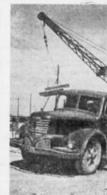
Coraz szerzej zastosowanie przy budowie własna Nowa Huta znajduje elementy prefabrykowane. Po raz pierwszy zastosowano je przy budowie osiedla A-11 oraz osiedla A-11. W najbliższym czasie ruszy fundamenty budowni się będzie z elementów prefabrykacyjnych: typy stopnice, schodowne, nadproża, gumy, balony i części odzobne budynków: kołunowy, balustrady balkonowe, atyki.
