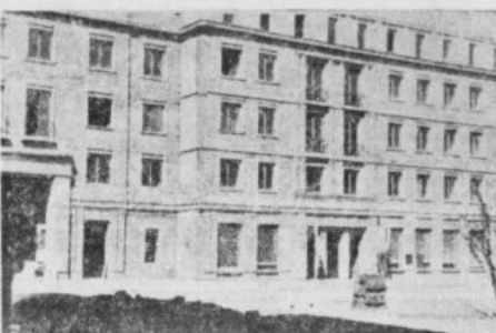
Przed kilkoma dniami czestochowska Działka oddala do użytku setny wybudowany na jej terenie przez ZRM w okresie od r. 1919 budowy mieszkalny w naszym mieście. Jest to widoczny na zdjęciu blok 14 w osiedlu kródniebskim za ratuszem.
