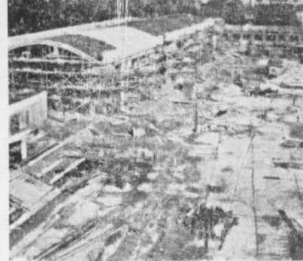
Prace przy budowie pałowni są jednym z etapów wstępnego budownictwa. Budynki zostały już całkowicie ukończone i pokryte dachem. (Fot. CAF Kondracki)
