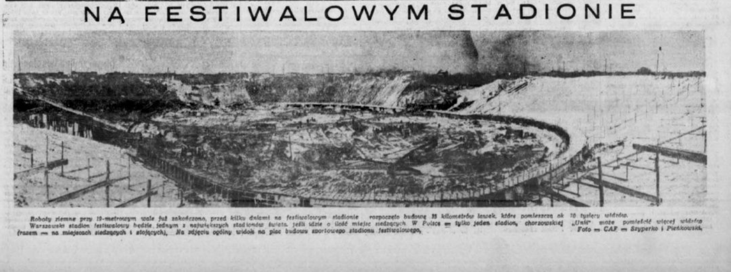
Roboty ziemne przy 15-metrowym osie już zakończona, przed kilku dniami na festiwalowym stadionie rozpoczęto budowę 35 kilometrów żelazek które pomieszcza ok 70 tysięcy widzów. Warszawa: stadion festiwalowy będzie jednym z największych w Polsce — tylko jeden stadion, chorwackiej 6 dywizji ośmiotokowych chińskich zostanie wycofanych z Korei. Pekin (PAP). Przedstawiciel ambasady chińskiej ośmiotokowych chińskich został zamknięty 25 bm. w km. i kwietniu zostanie wycofanych z Korei 6 dywizji chińskich ośmiotokowych chińskich. Zakomunikował on ponad to, że dowódca chińskich ośmiotokowych chińskich, gen. Jan Jung.
