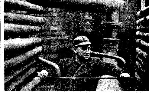
Przez długie linie przewodów rurkotagowych wtryskiwane będą w wypadkach podziemnej kurawki środki chemiczne, które zamarzną gruntu do minimum 28 stopni. W tuarzej, lodowociepłej ziemi latwo będzie można głąbić szyby warszawskiego metra.
