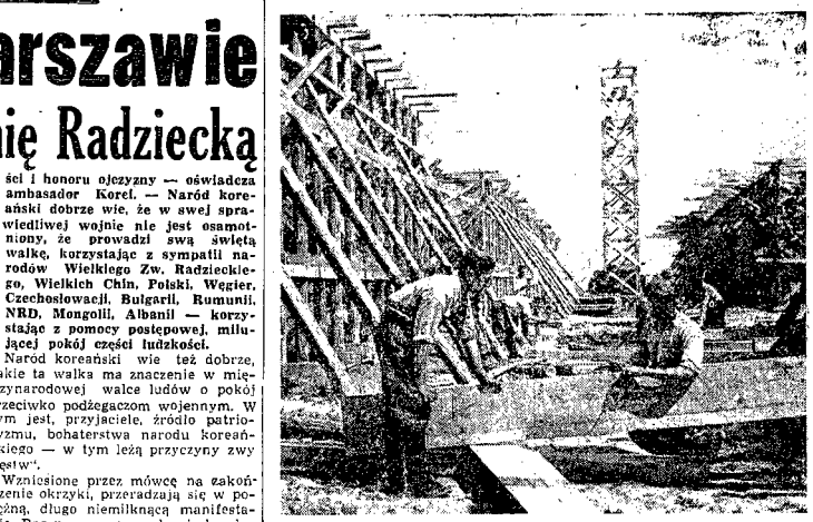
Szybko postępuje budowa fabryki samochodów ciężarowych w Lublinie. W roku 1952 mają być przecięt wyjść z niej pierwsze samochody. Na zdjęciu: robotnicze hale jeszcze oszalowane drewnem. Foto GdP — Z. Włodarski
