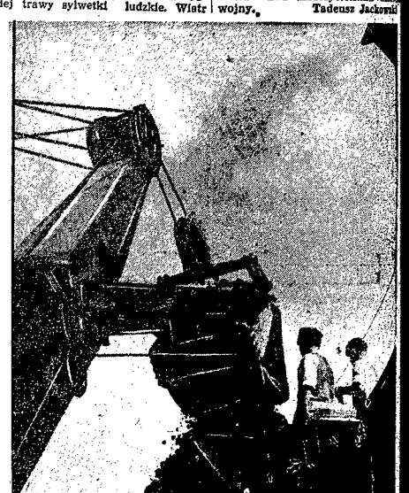
Kopaczki, budującej torujską drogę rozwiązującej się wspaniale Warszawy. Najnowocześniejszy sprzęt budowlany ma być używany do piętnięcia dzielnic. Niezależnie przysięgli. Warszawa robotniczy i ich święty sprzęt są już arcyważną rolę w życiu i kulturze wielkiej Warszawy.
