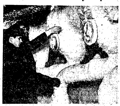
Przy budowie nowych kopalń dużą przeszkodą jest ten, kurzuwka (narusza ziemi pomieszczonej z wodą podłożną, obniżająca się latowo). Kurzuwka nie pozwala na szybkie drążenie ziemi w głąb. Obecnie stosuje się specjalne aparaty zamrażające ziemię, które będą też zastosowane przy budowie nowych kopalni, w miejscach, gdzie woda podłożna krąży się z tunelem metra. Na zdjęciu: komora zamrażająca, w jednej z nowych kopalni. Idące w głąb przewody zamrażają ziemię. Foto A.R.
