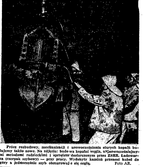
Próbę rozbudowy, mechanizacji i unowocześnienia starych kopalń budujemy także nowo. Na zdjęciu: budo w kopalni węgla „Mnówce” wsiadymi metodami radzieckimi i sprzętem dostarczanym przez ZSRR. Ładowniak (czepak szary) — przy pracy. Wydobyt kamień przelosi kubel do góry a jednocześnie szyb obmurują się cęgla. Foto AR.
