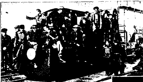
Robotnicy Centralnych Warsztatów Samochodowych wybudowali z wraka ciągnika przetaczkę, która użyta będzie przez CPN do przetwarzania cysteren naftowych
