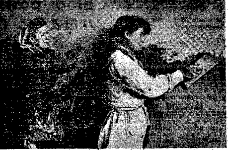
Coraz więcej kobiet pracuje w budownictwie. Można tu zobaczyć murarza — kobietę wykonującą prace tynkarskie w jednej z pracujących w Warszawie.
