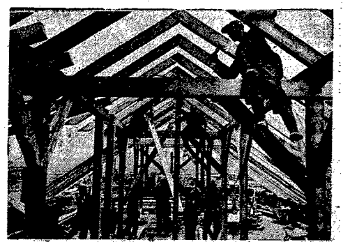
W Kragorach, koło Krakowa, wyrosła nowa dzielnica domów mieszkalnych. Na zdjęciu robotnicy kładą dach na jednym z domów.
