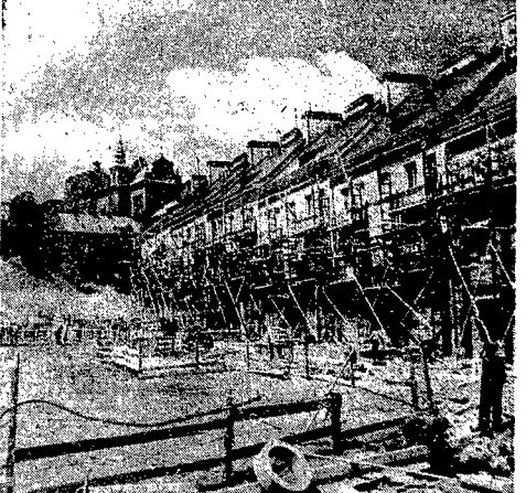
W Osiedlu Marstonowskim wybudowano za czasów nowego zarządu domki, które w ostatnim etapie prac otrzymują kolorowe elewacje zewnętrzne. Jedno z osiedli budowanych osiedla osiemnastu do dn. 28 lipca kiedy znikną z murów ostatnie rusztowania.
