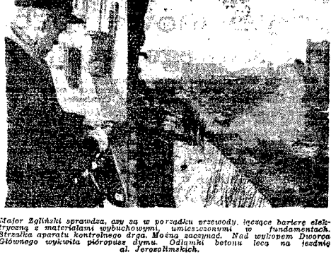
Roboty budowlane przy wysadzaniu fundamentów Dłorca Głównego.
