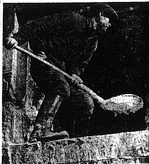
Wyczerpana się z ciepła fotograficzna chwytała na gorąco, bez pozostawiania. Do takich należy fotografia p. t. „Lopata” wykonana przez Zofię Burzyńską. Przedstawia ona murarza przy pracy, mieszającego wapno. Fotografia ukazywała murarza na konkursie Pol. Tow. Fotograficznego, urządzonym w Warszawie pod hasłem „Praca robotnika i rolnika”.
