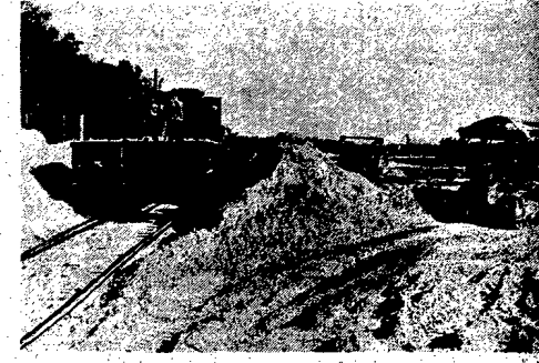
W pobliżu Szczecina buduje się obecnie wielka stacja rozrządowa, która umożliwi... W pobliżu Szczecina buduje się obecnie wielka stacja rozrządowa...
