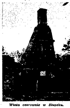
Wieża ciżworonia w Słupsku.
