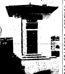
Budynek przedwojennej stacji mareograficznej w Gdyni (złoty punkt).
