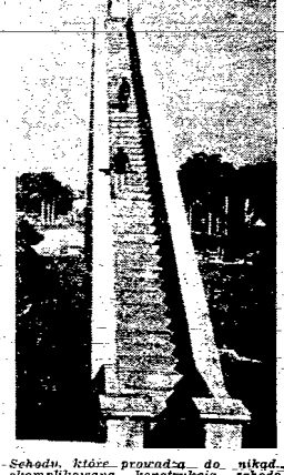
Schody, które prowadzą do nikąd... skomplikowana konstrukcja schodów, która służyła do pomiarów, związanych z ruchem ciał niebieskich.
