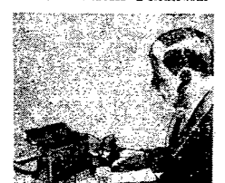
Niewidomy prowadzi paletką fotoelektryczną po wierszach druku; każde litere odpowiada specjalny dźwięk
