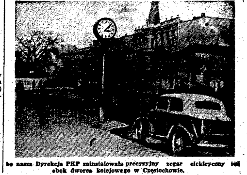
be nazwa Dyrekcja PKP zainstalowała precyzyjny zegar elektryczny obok dworca kolejowego w Częstochowie.
