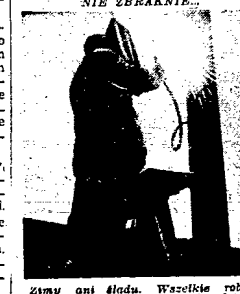
Zimny ani śniegu. Wszelkie roboty uliczne muszą być wykonane latem i w sieni kablowej mogą odbywać się bez żadnych przerw.
