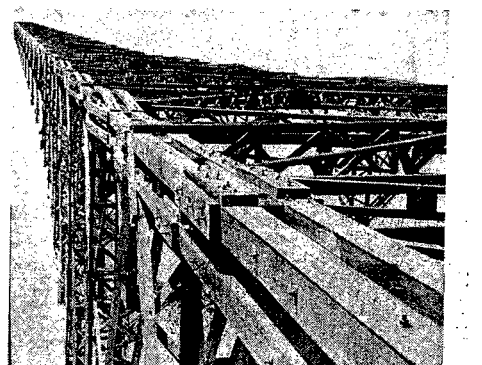
Masz radiostacji we Wrocławiu mierzy 160 m wysokości i jest jednym z najwyższych w Europie. Osobliwością masztu jest jego drewniana konstrukcja.
