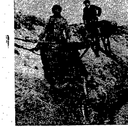
Na podmokłych polach wawerskich oczyszcza się rowy odwadniające. Robotę ciężką, musi być jednak wykonaną przed zimą, by wiosną, spływająca woda nie zalala niśbo położonych pól, co odbiło się ujemnie na rolnictwie.
