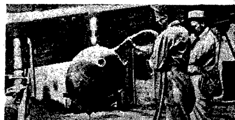
Już zamocowaną pod skrzydłem samolotu bombę wodną, trzeba wypełnić wodą.
