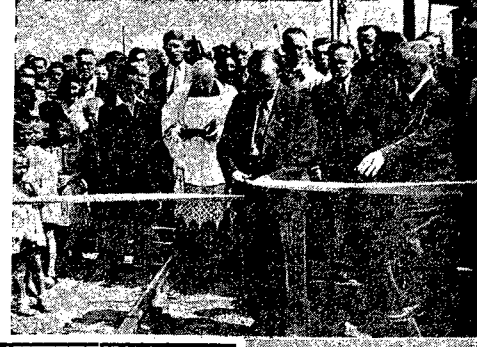
Na stacji Nasielsk wicemin. Balicki dokonuje otwarcia nowego toru, łączącego Nasielsk ze Słotką. Na zdjęciu: minister przemysłu i handlu, wicemin. Balicki oraz urzędnicy przelaz pierwszego pociągu przez bramę tramtarną zbudowaną rękami kolejarzy, którzy układali nowy tor.
