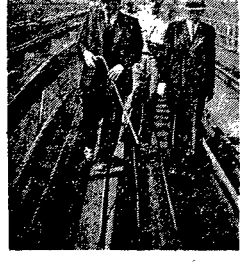
Most kolejowy pod Cytadłą w Warszawie. Inż. Ciesiewski (pośrodku) kierownik nadzoru budowy jest ostatnio częstym gościem na moście. W tle: zwizujący zwyczajni współpracownicy inżyniera budowę torów.
