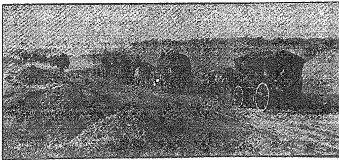
Zaopatrywanie przyczółka mostowego nad Kubanią
