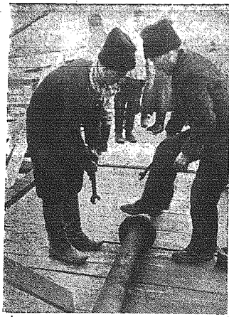
Robotnicy rumuńscy budują nowy rurpąg prowadzący przez pontonowy most na Dunaju. Rurciągiem tym dostarczana jest oliwa dla wojsk niemieckich w Bułgarii.
