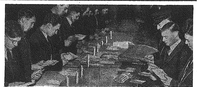
«Tymczasowe» biuro pocztowe. Podczas jednego z ostatnich ataków lotniczych na Londyn zburzony został tam powien urząd pocztowy. — Na zdjęciu widzimy pracowników tego urzędu, pracujących w piwnicy przy świeczkach.
