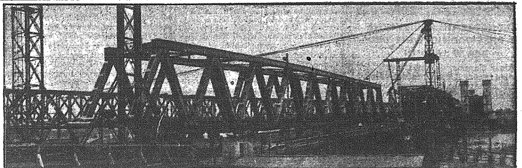
Odbudowa kraju po działaniach wojennych w ubiegłym roku, postępuje naprzód. Mosty, drogi i linie kolejowe naprawiane są w pierwszym rzędzie. — Na zdjęciu widzimy odbudowę mostu na Wiśle. Jest to most w Tczewie, wysadzony we wrześniu 1939 roku.
