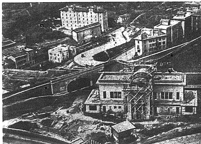
Dworzec kolejowy podczas budowy.
