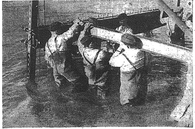
Zdjęcie nasze przedstawia fragment prac pionierów przy budowie pomostu do lądowa- nia. Żołnierze ubrani są w specjalne ubrania gumowe, które chronią ich przed skutkami długotrwałej pracy w wodzie.
