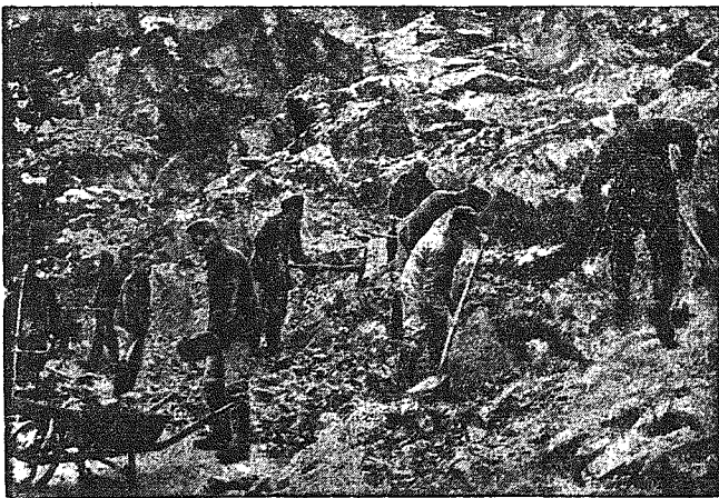
KOMPANIA BUDOWY DRÓG NA STANOWISKU NA ZACHODZIE. Niezliczona ilość odłamków kamieni jest potrzebna do gruntownej budowy dróg.
