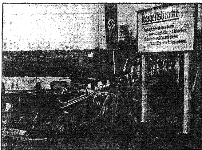
ODBUDOWA MOSTU W OBERSITZKO. W ciągu 55 dni pracy oddziały budowlane i Służby Pracy odbudowały 110 mtr. długości liczący most w Obersitzko. Na ilustracji Gauleiter Greiser i generał Petzel przejeżdżają po raz pierwszy przez most.
