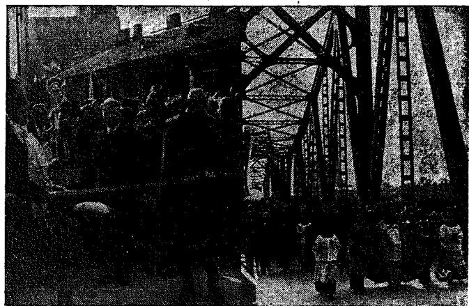
Uroczystość poświęcenia mostu im. Marszałka Edwarda Śmigłego - Rydza we Włocławku. W sobotę odbyła się we Włocławku uroczystość poświęcenia nowozbudowanego mostu stalowego im. Edwarda Śmigłego - Rydza. Most ten, który połączył oba brzozy Wisły, posiada rozpiętość 619 mtr. przy 120 mtr. długości wiaduktu żelbetowego. Uroczystego aktu poświęcenia mostu dokonał J. E. ks. biskup Radoński, w asyście liczne go duchowieństwa, zaś p. marszałek Śmigły-Rydz przedzielił symboliczną wstęgę. Odbyła się również uroczystość nadania panu marszałkowi Śmigłemu - Rydzowi przez Radę Miejską m. Włocławka obywatelstwa honorowego. Zdjęcie przedstawia w fotomontażu: na prawo — moment przecięcia symbolicznej wstęgi przez p. marszałka Śmigłego - Rydza w towarzystwie ministra Ulrycha — jako akt otwarcia mostu, na lewo moment poświęcenia mostu przez J. E. ks. biskupa Radońskiego.
