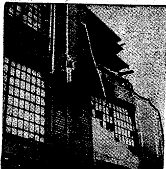
Groźny wybuch kotła w fabryce łódzkiej. Na zdjęciu naszym widzimy budynek fabryki połączony z F-my Zakrzewskiej w Łodzi, zrujnowany przez wybuch kotła. Na skutek wybuchu 10 osób zostało ciężko poparzonych.
