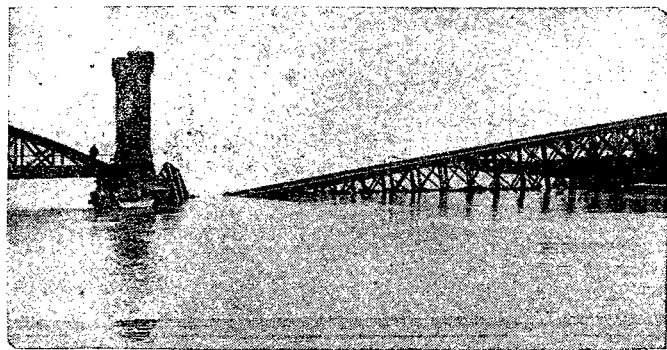
Zerwany most. Most żelazny kolejowy, łączący duńskie wyspy Laaland i Zelandię, został zerwany przez przepływający pod nim angielski statek cysterna „Artherton”. Wskutek zerwania mostu wstrzymana została na tym odcinku komunikacja między Niemcami i Danią. Na zdjęciu — zerwany most.
