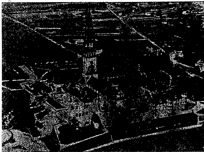
Zdjęcie Jasnej Góry z samolotu doskołałe uwidacznia mury fortyfikacyjne, otaczające klasztor z bastionami po rogach.
